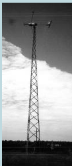
Figure 9: Éolienne Bergey Excel de 10 kW destinées aux activités de R.-D. sur les convertisseurs
