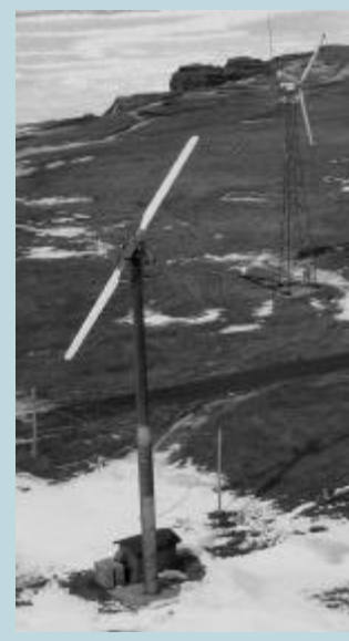
Figure 10: Éolienne Lagaway LW18 de 80 kW destinées aux activités de R.-D. sur les convertisseurs
